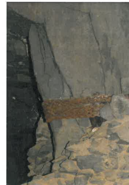
Versagen einer historischen Pfeilersicherung
